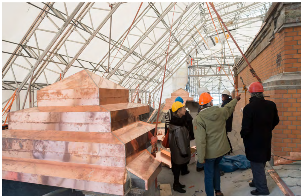
Taket på KODE 1 ble i 2015 skiftet ut, som del av en omfattende oppgradering av hele bygget.
